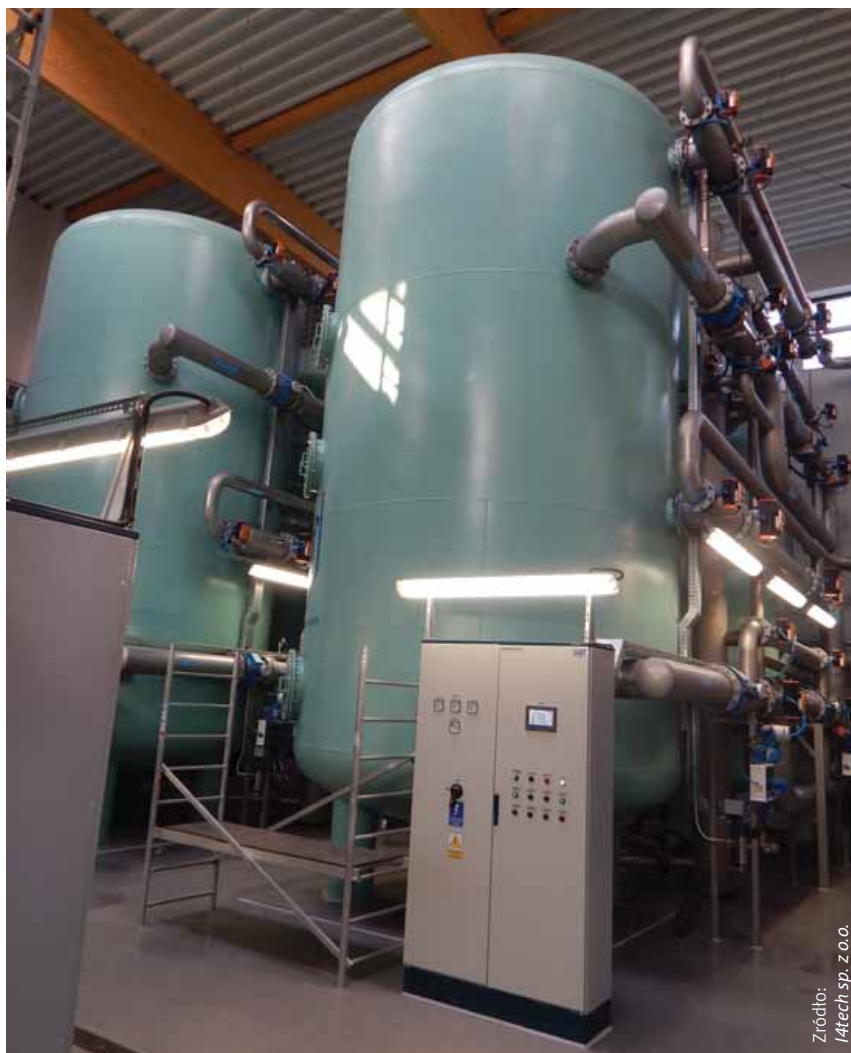
Rysunek 1 Stacja uzdatniania wody jako przykład zastosowania pompy wolumetrycznych
