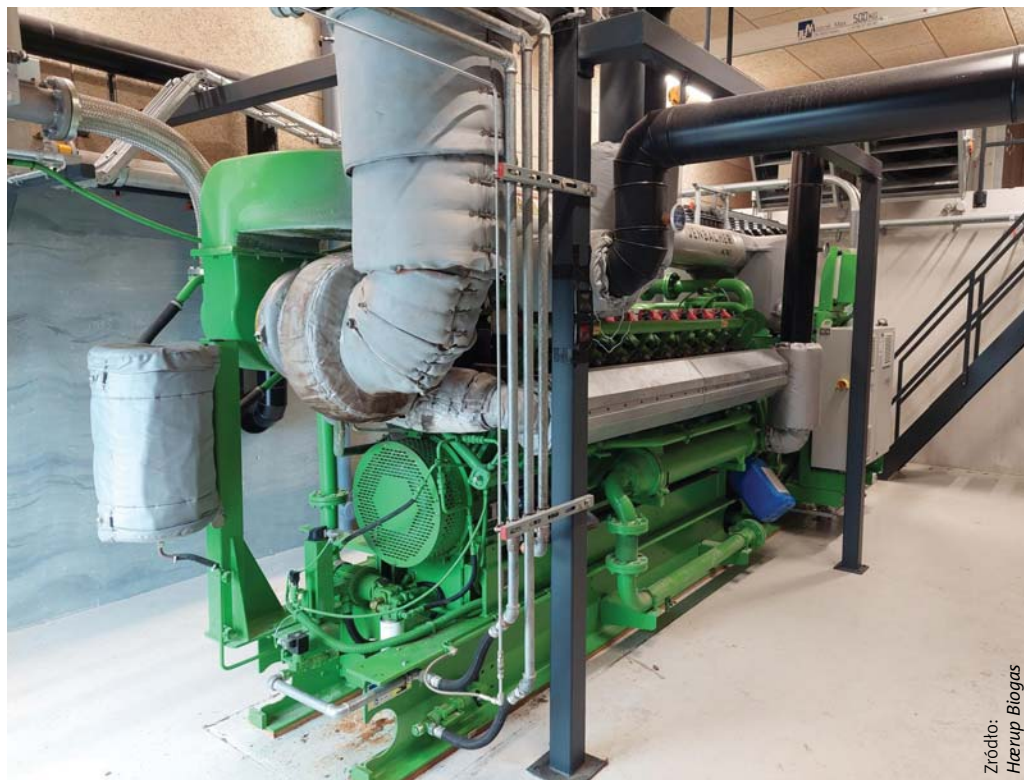
Rysunek 1 Silnik instalacji kogeneracji
