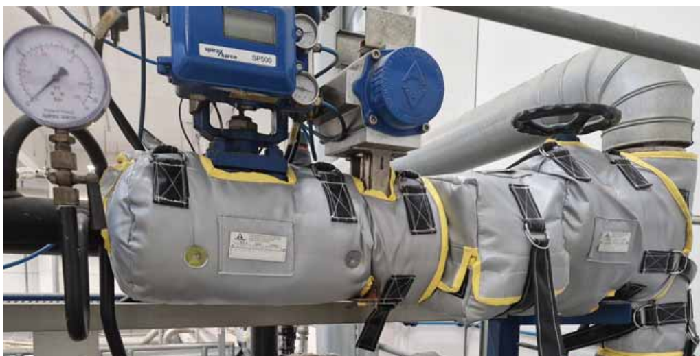
Rysunek 7 Systemy mocujące gwarantujące łatwość demontażu/montażu izolacji
