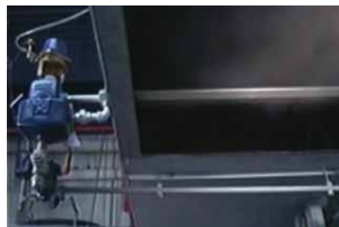
Rysunek 2 Kanałowy nawilżacz z pojedynczą lancą wtryskową pary w kanale powietrza
