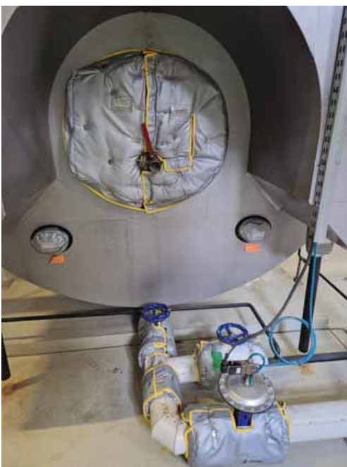
Rysunek 2 Izolacja kotła parowego
