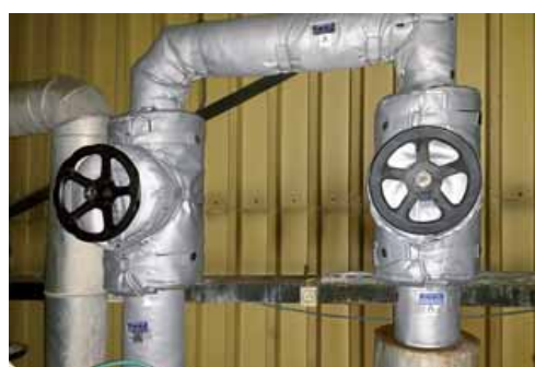
Rysunek 7 Stosowanie płaszczy izolacyjnych zmniejsza straty ciepła
