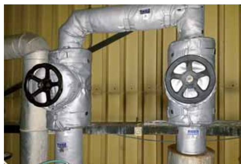
Rysunek 7 Stosowanie płaszczy izolacyjnych zmniejsza straty ciepła
