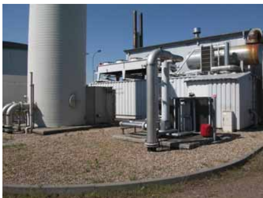
Typowa jednostka kogeneracyjna
