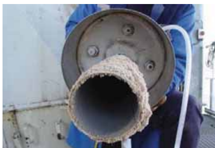
Anteny tubowe z układem nadmuchu sprężonego powietrza
