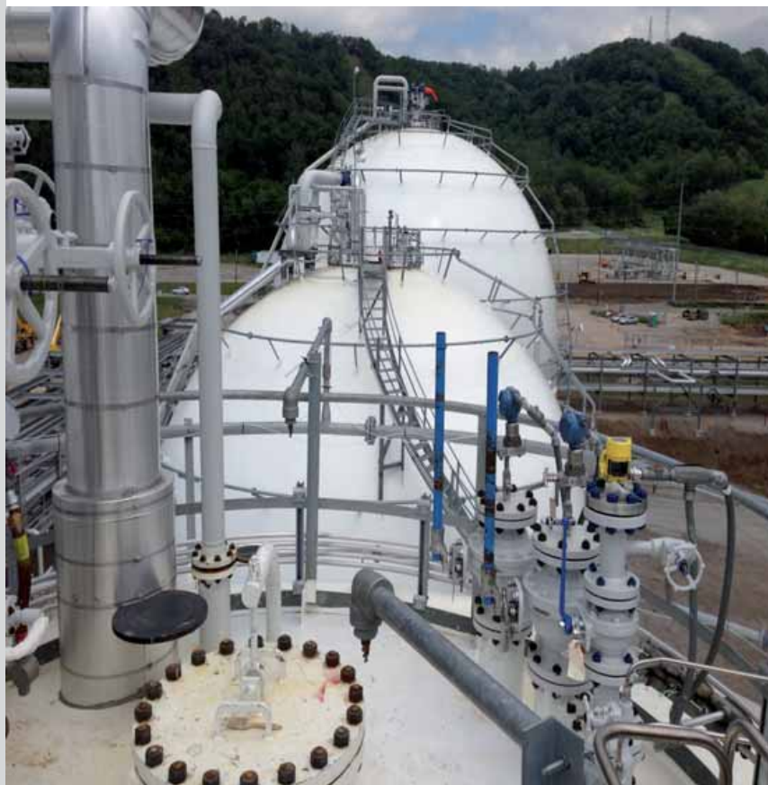
Rysunek 3 Sonda Vegapuls 64 zamontowana na dachu reaktora
