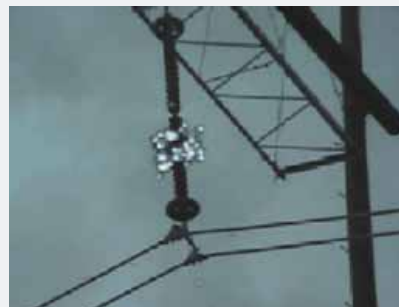
Wyładowanie koronowe – zdjęcie z kamery UV
