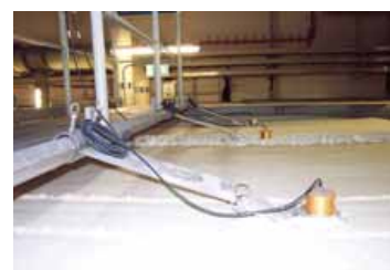
Pomiar gipsu na taśmociągu w trzech punktach
