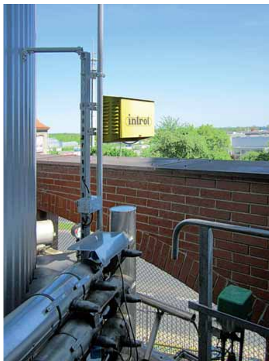
Detektor \text{NH}_3 z systemem zraszającym
