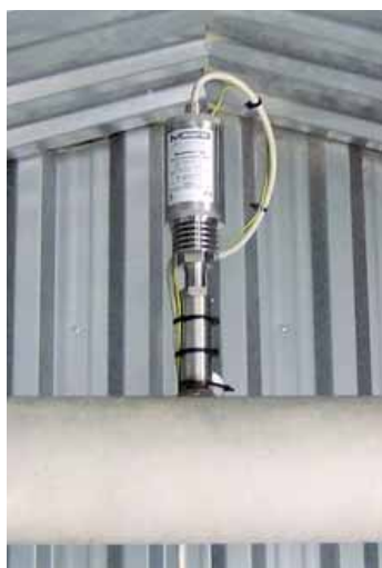
Zabudowany przepływomierz do pyłu
