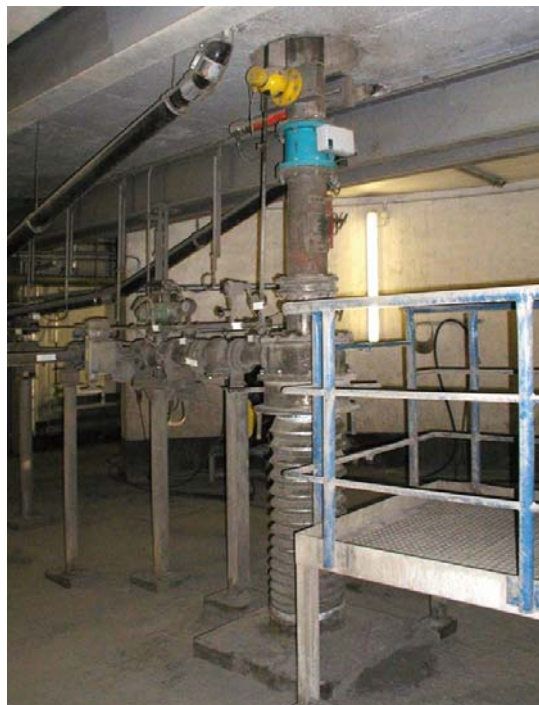
Układ pomiaru przepływu mączki wapiennej
