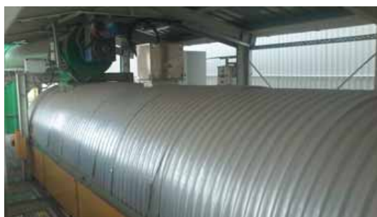
Układ skanera zamontowany na zewnętrznym, zamkniętym przenośniku z biomasą
