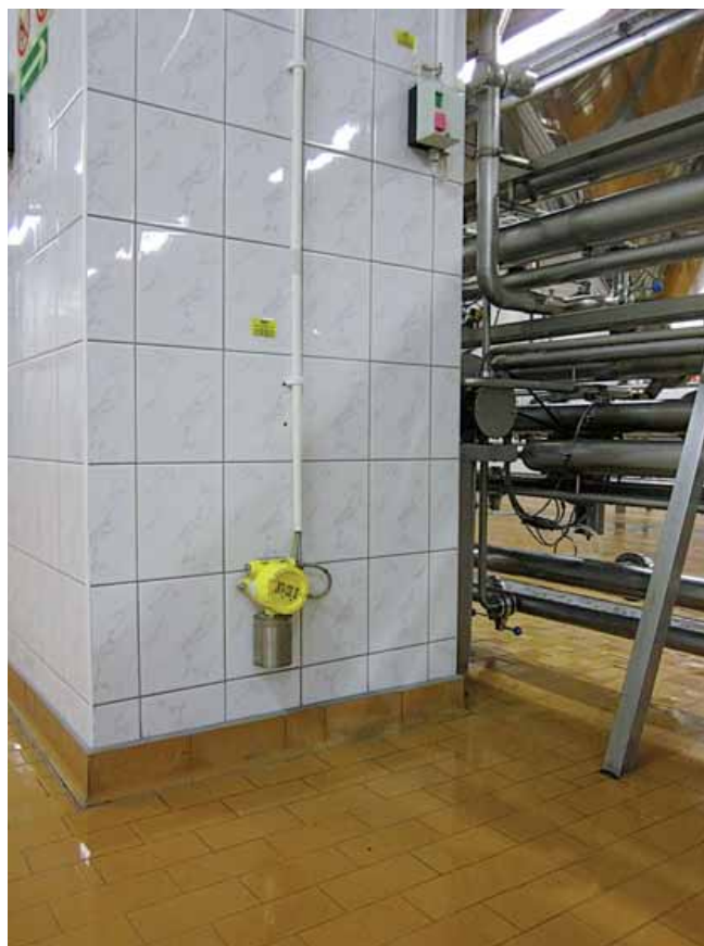
Detektor CO 2 w osłonie bryzgoszczelnej
